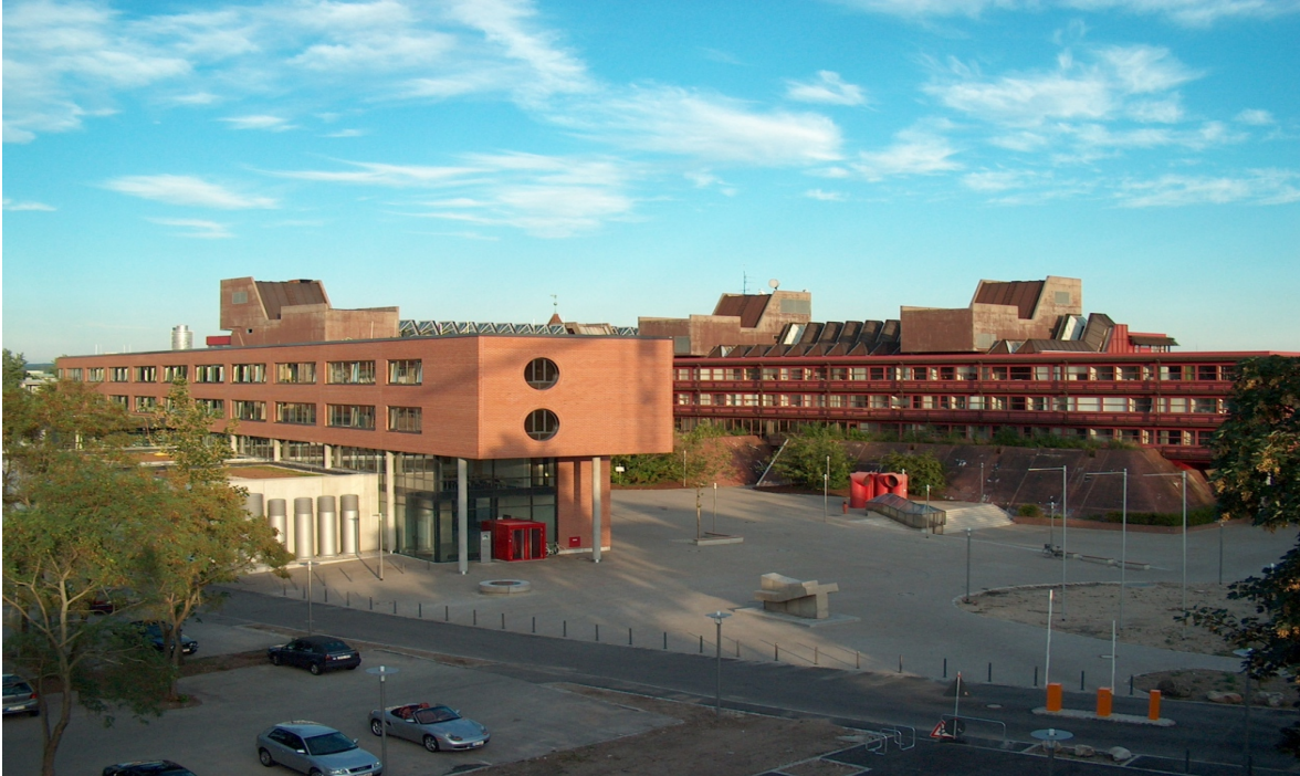
Bild 1: Der Fachbereich Wirtschaftswissenschaften im Herzen der Nürnberger Altstadt (11323 - Bild: Pressestelle FAU)
